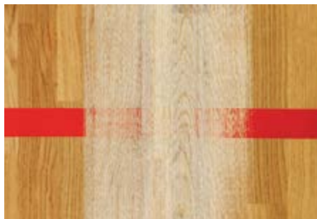
Os abrasivos da concorrência não eliminam por completo o verniz antigo nem as linhas de marcação.
