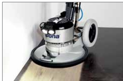
Slipar nära väggen och minimerar kantslipning
